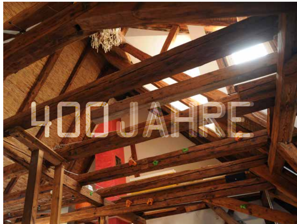
Früher wurde ein Haus »für die Ewigkeit« gebaut; warum sollte das heute nicht mehr gelten – auch und gerade für Holzhäuser? Links ein 400 Jahre altes Fachwerkhaus, rechts ein Rohbau von MÜLLERS BÜRO von 2013.
