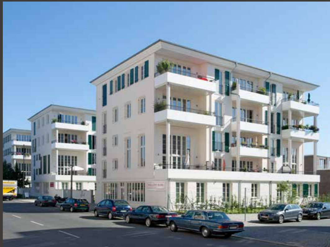
Mit neuen Ideen vorangehen: die ersten drei fünfgeschossigen Passivhäuser in Holzbauweise entstanden im Berliner Stadtteil Prenzlauer Berg mit Müllers Büro.
