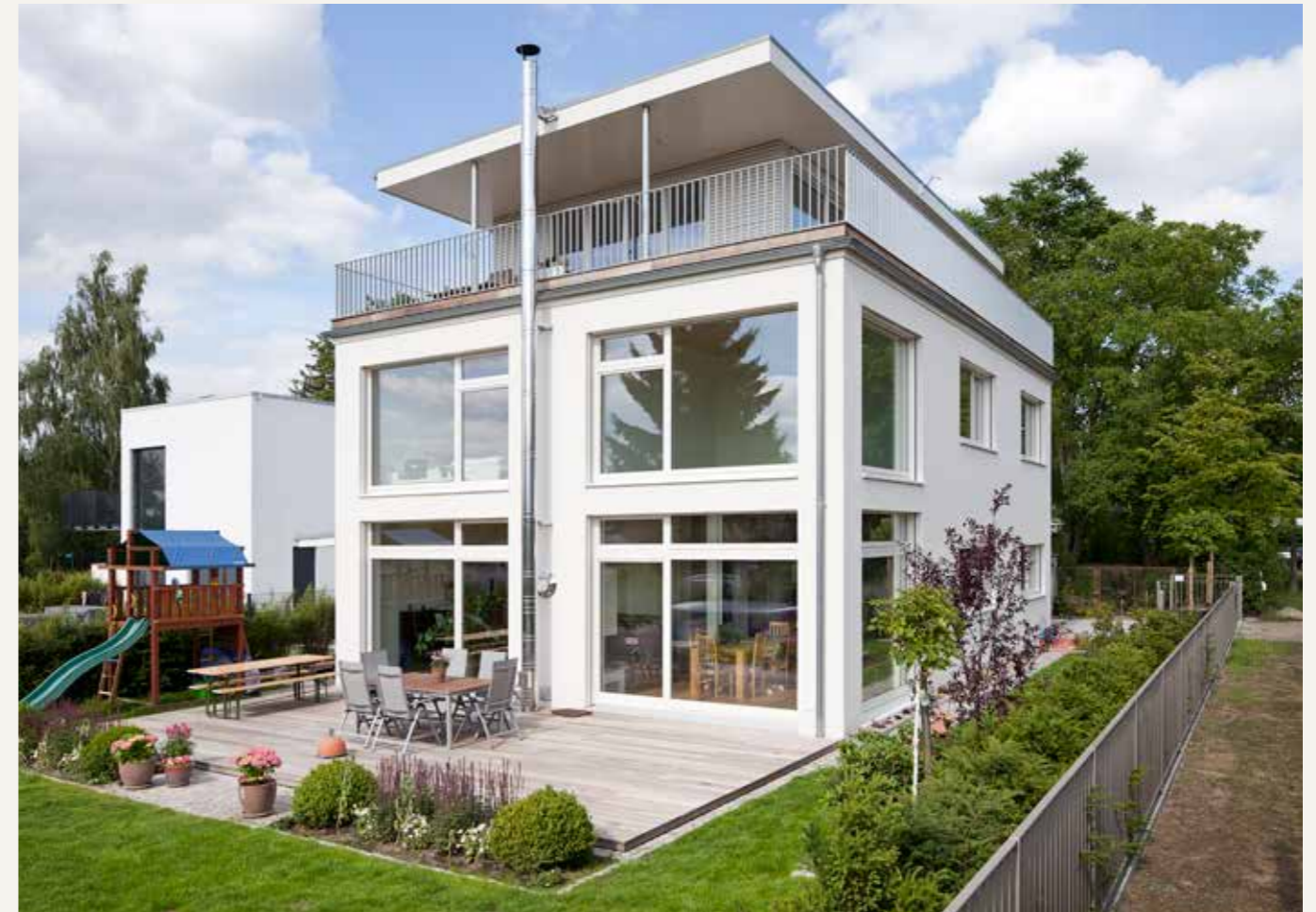
Im Juni 2013 wurde Richtfest gefeiert – diese Fotos entstanden im Juni 2014
